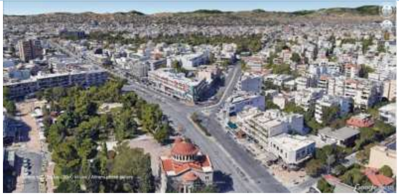
Πλατεία Αγίας Παρασκευής – διασταύρωση Λ. Μεσογείων με Λ. Χαλανδρίου
